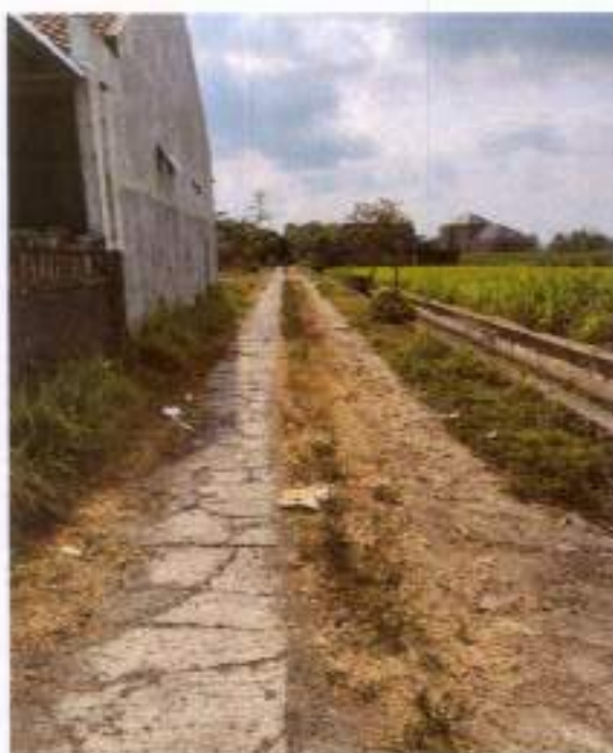
Pengerasan Jalan Padukuhan Bedilan
