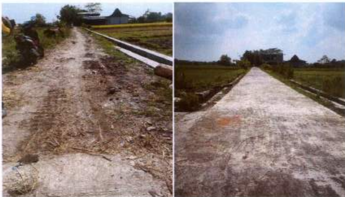
Pengerasan Jalan di Padukuhan Sumber Kulon
