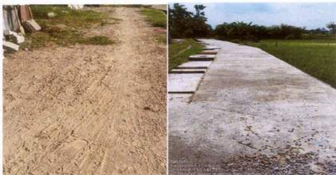
Pengerasan Jalan di Padukuhan Baran
