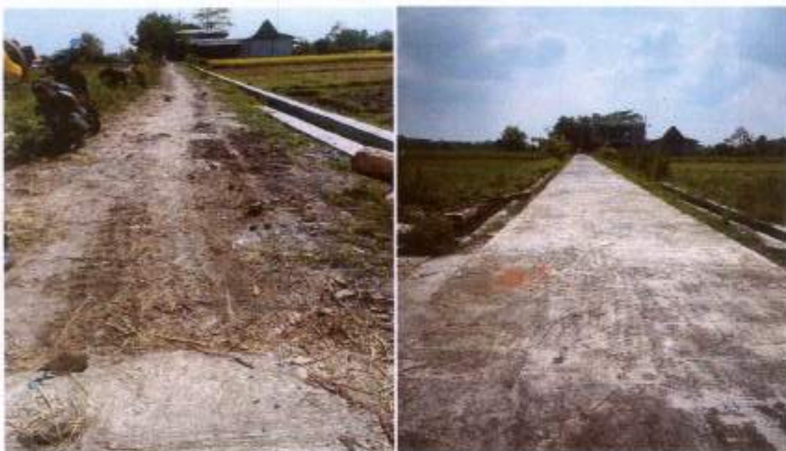
Pengerasan Jalan di Padukuhan Sumber Kulon
