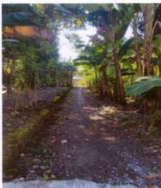
Pengerasan Jalan di Padukuhan Kaliajir Lor
