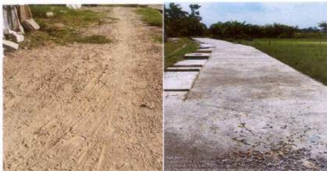
Pengerasan Jalan di Padukuhan Baran
