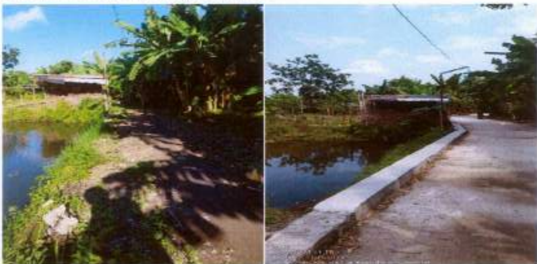
Pekerjaan Talud Padukuhan Kaliajir Lor
